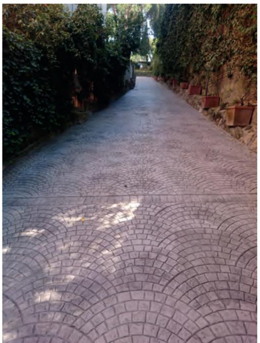
L'intervento è stato eseguito sulla rampa esterna carrabile dell'edificio condominiale la quale presentava fenomeni di degrado dovuti a diversi fattori che si erano presentati nel tempo. I lavori hanno previsto la rimozione del pacchetto di pavimentazione fino allo strato di sottofondo, il suo ripristino, la stesura di telo di tessuto non tessuto. Si è poi passati alla realizzazione di una pavimentazione a stampo in c.a. giuntata e sigillata con silicone.
